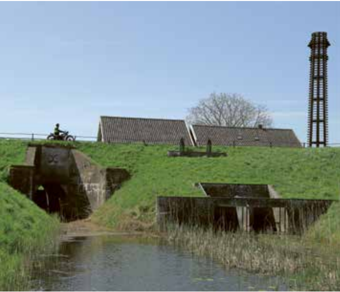
Het gemaal Oude Rijn in Pannerden: nieuwe functies Het voormalige stoomgemaal uit 1884 werd overbodig nadat in 1970 de Oude Rijn van het Pannerdens Kanaal werd afgesloten. De functie werd overgenomen door een nieuw gemaal dichtbij het kanaal. Het gemeentelijk monument werd in 2015-2016 gerestaureerd, waarbij de contour van de schoorsteen in de vorm van een stalen frame werd teruggeplaatst. Het ketelhuis en de loods zijn in gebruik als expositieruimte, educatief centrum en bed & breakfast.
