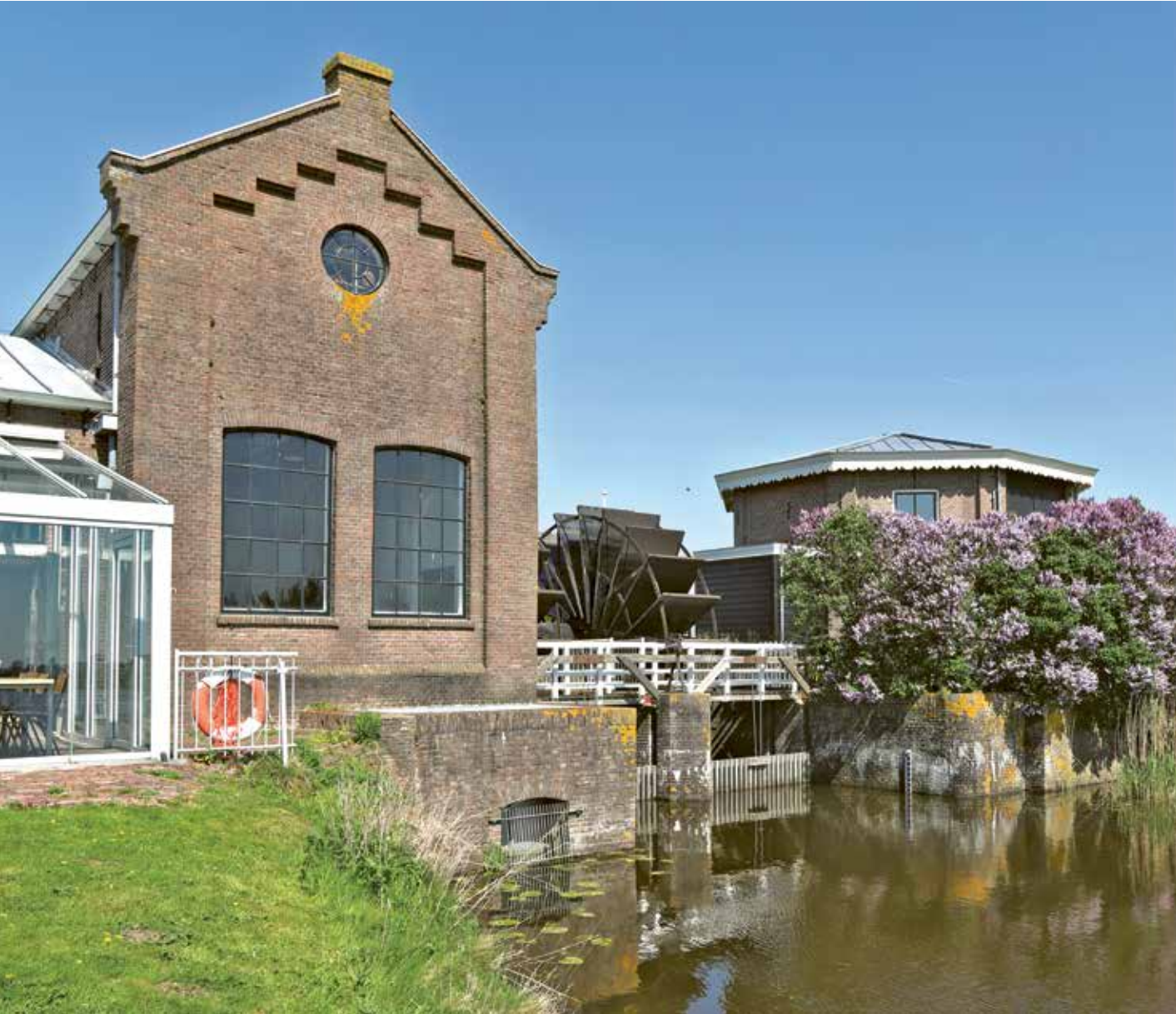
Stoomgemaal Hertog Reijnout in Nijkerk: werkt nog Dit gemaal in de Arkemheerpolder was van 1883 tot 1983 als stoomgemaal in functie en looste het overtollige water van de laaggelegen polder op de (voormalige) Zuiderzee. Onder extreme omstandigheden kan dit rijksmonument nog steeds bijspringen.
