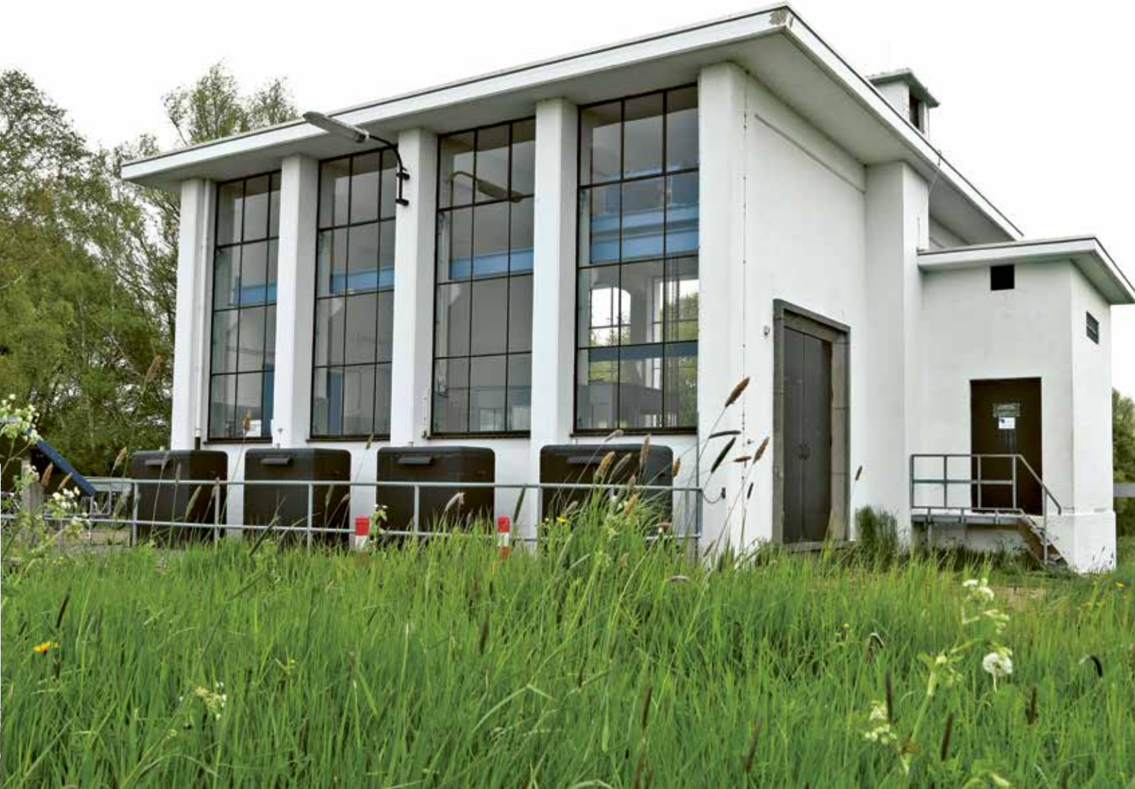
Gemaal De Grote Beek in Bronckhorst: wederopbouwpareltje Het gemaal met dienstwoning uit 1953 is een gemeentelijk monument. Het is een mooi voorbeeld van wederopbouwarchitectuur met kenmerken van het 'Nieuwe Bouwen'. Het gemaal ligt in de Grote Beek en op de Usseldijk met prachtig uitzicht over de Ussel. In de dienstwoning met een eigentijdse aanbouw is het Kunstgemaal en Keukengemaal gevestigd.
