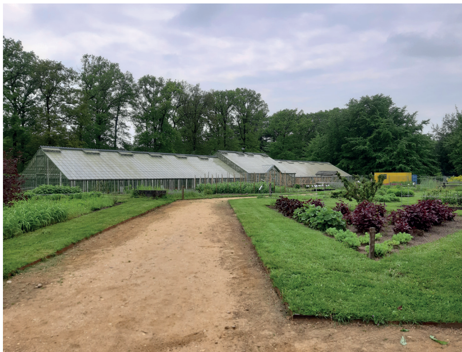
Renovatie van de kas bij Jachtslot Mookerheide. De grote of koude kas dateert van omstreeks 1928 en is sinds de bouw niet in hoofdvorm veranderd. De hele aangetaste buitenschil wordt vervangen, waarbij niet aangetaste delen, met name in het interieur, waar mogelijk worden hergebruikt.
