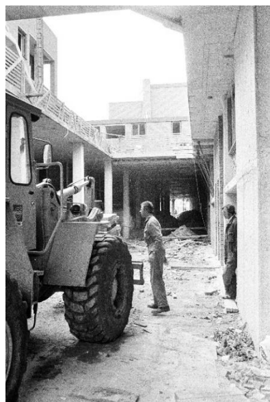
Figuur 82: Tijdens de bouw in 1978 is te zien dat in de dekvloer een sparing is gelaten tussen stramien 6 en 7 en tussen E en H.
