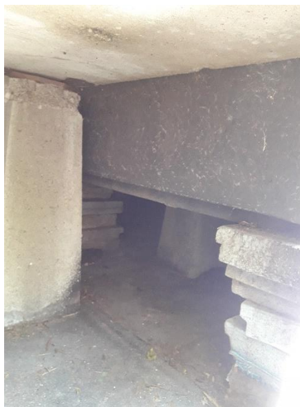
Figuur 75: Zicht op de plantenbak vanuit de kruipruimte onder de straat. De plantenbakken staan op blokken piepschuim.
