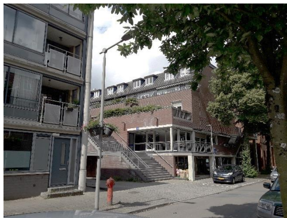
Figuur 44: Huidige toestand van de entree aan de Vossenstraat. De trappen zijn aangepast tot een rechte trap en er zijn bordessen gemaakt op twee niveaus.
