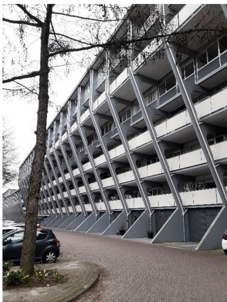
Figuur 2: Noordgevel met galerijen en overkragingen.
