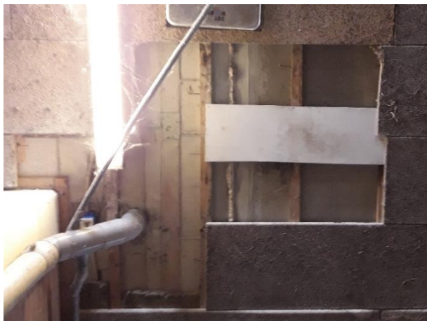
Figuur 81: Plafond van de parkeergarage, waar de overgang tussen in het werk gestort beton (links) en prefab beton (rechts) zichtbaar is.
