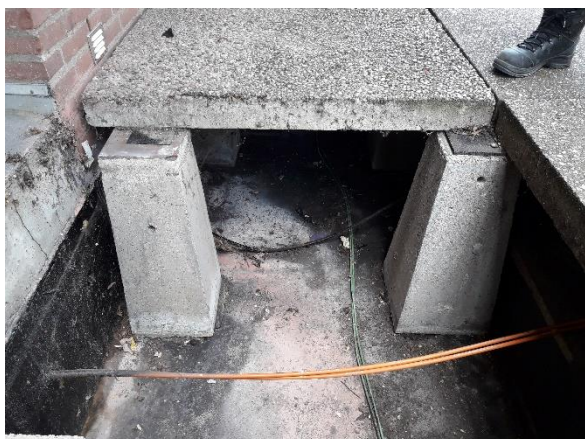
Figuur 64: Kruipruimte onder de grindtegels onder de straat.
