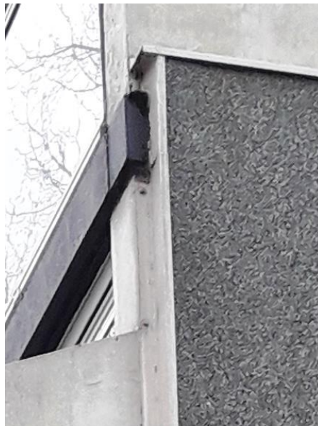
Figuur 22: Kopgevel ter hoogte van de oplegging van het terrasbalkon. Het aluminium zetwerk is enkele centimeters hoger gepositioneerd dan het niveau van het prefab balkon.
