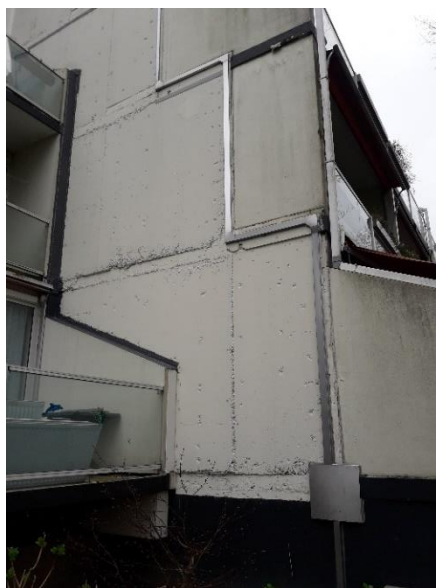
Figuur 11: Kopgevel, waar tijdelijk de bekleding is verwijderd.
