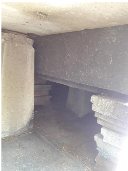
Figuur 112: Plantenbak vanaf de kruipruimte onder de straat. De bakken staan op blokken, waardoor eronder vrije ruimte is voor waterafvoer.
