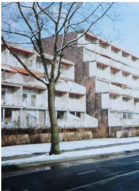
Figuur 17: Zuidgevel met nog aanwezige, sterk verkleurde Eternit leien op de kopgevel. De foto is genomen na de situatie in figuur 16, maar dateert van vóór 1995; een exacte datering ontbreekt.
