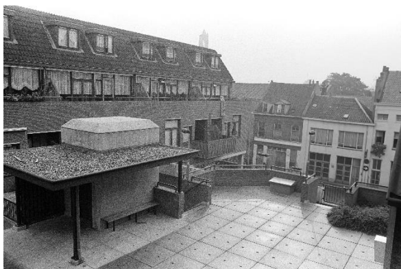
Figuur 62: Situatie in 1981 van de entree aan de Vossenstraat vanaf het dek gezien. De grindtegels zijn zichtbaar.
