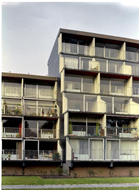
Figuur 16: Zuidgevel op 30 oktober 1974, direct na voltooiing van het werk. De kopgevels zijn afgewerkt met antracietkleurige leien.
