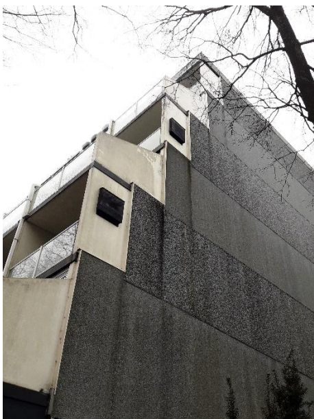
Figuur 18: Kopgevel met nieuwe gevelbekleding ter vervanging van de Eternit leien.
