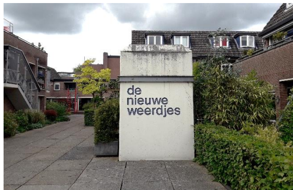
Figuur 46: Huidige toestand vanaf de entree, zicht op de Molenkom en de lift. De opstaande muren zijn verwijderd en de vloer is verhoogd vanaf waar de foto genomen is.
