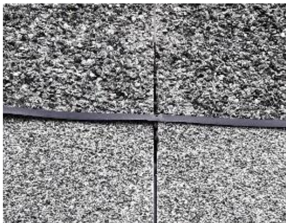
Figuur 19: Gevelbekleding met afdichting in de horizontale naden.
