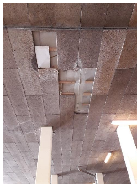
Figuur 60: De houtwolcementplaten zijn verwijderd waar lekkages zijn geconstateerd en waar reparaties zijn uitgevoerd.
