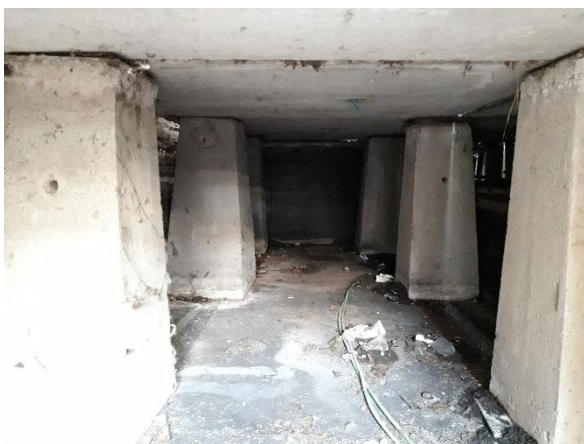
Figuur 117: Zicht in de kruipruimte onder de straat, waar de hoeveelheid vuil beperkt is.
