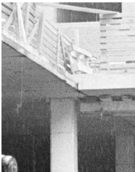
Figuur 83: Ingezoomd op figuur 82. De sparing werd gevuld met prefab betonelementen.
