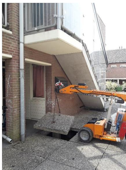
Figuur 119: De tilmachine in actie, waarbij een grindtegel wordt opgetild.
