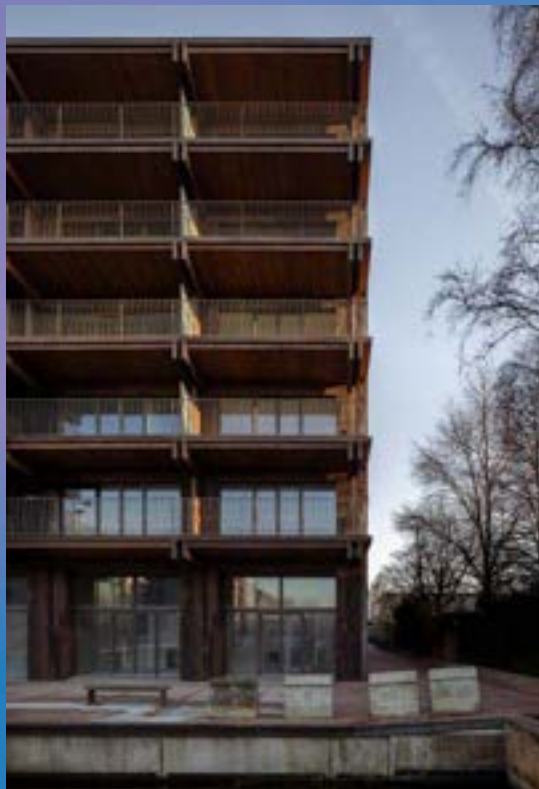
Afbeelding 39, 40 & 41. Het appartementencomplex Houtrak heeft gerecycled Azobé houten gevels en massief houten balkons, en is opgebouwd uit houten kolommen en prefab betonplaten. Zo is een flexibel casco ontstaan met flexibiliteit in de indeling en het gebruik. Houtrak Amsterdam (2025), Marcel Lok Architecten in samenwerking met Workshop Architecten en Flux Landscape. Foto: Anna Odulińska.
