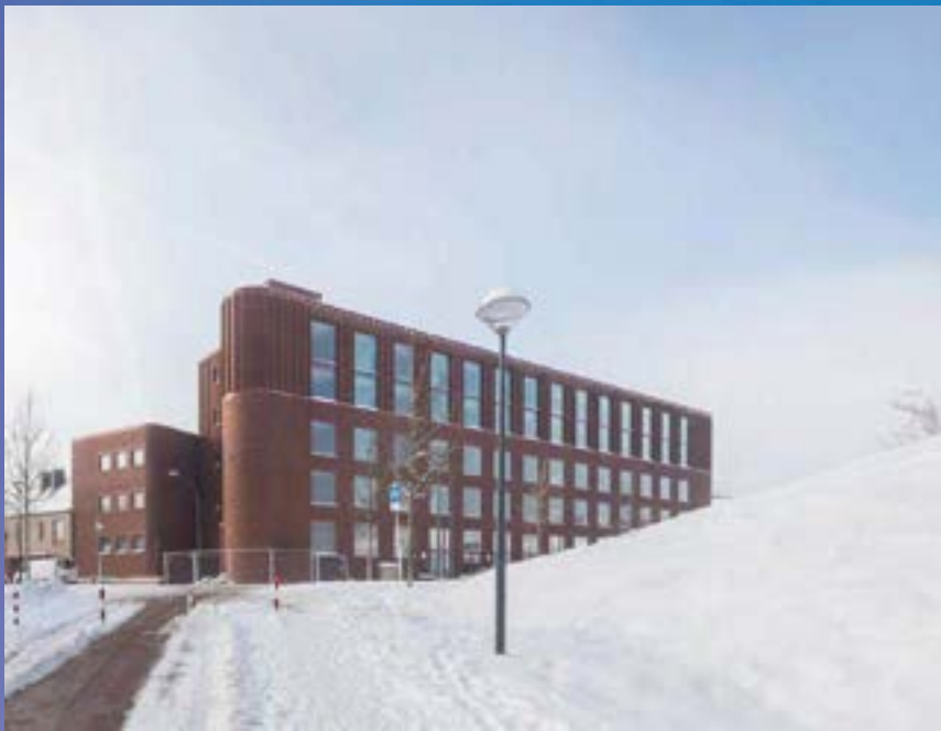
Afbeeldingen 34 & 35. Aan de noordrand van De Groene Loper in Maastricht vormt Miller II (2024) een schanierpunt tussen de bestaande wijk Wyckerpoort, en de openbare ruimte bovenop de A2. Het uit rood baksteen opgetrokken volume, met daarin 38 appartementen, schermt de achterliggende wijk af van geluid. Accenten zijn uitgevoerd in een rood geflazeerde steen. Ontwerp: Martens Willems architecten. Foto: Arjen Schmitz.
