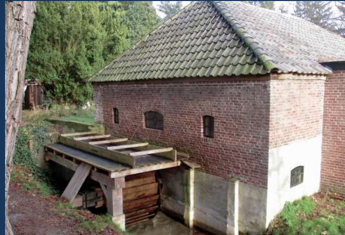
De Quadenoordse Molen in Renkum is een voorbeeld van een bovenslagmolen aan een opgeleide sprengbeek. © Pim van Tend
