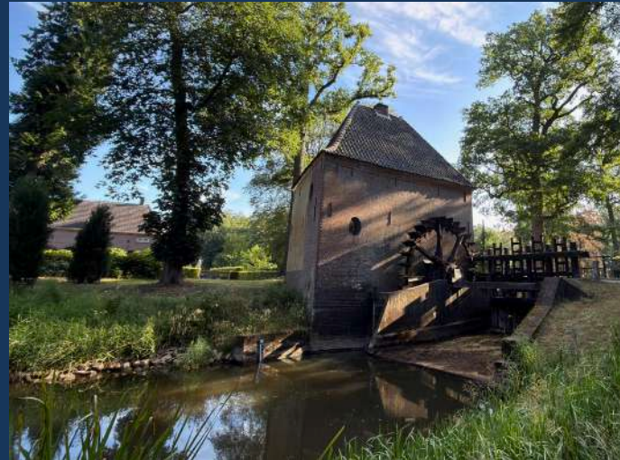
De watermolen bij landgoed Hackfort in Vorden is een voorbeeld van een watermolen met onderslagrad. © Gerrit van de Pol, Monumentenwacht
