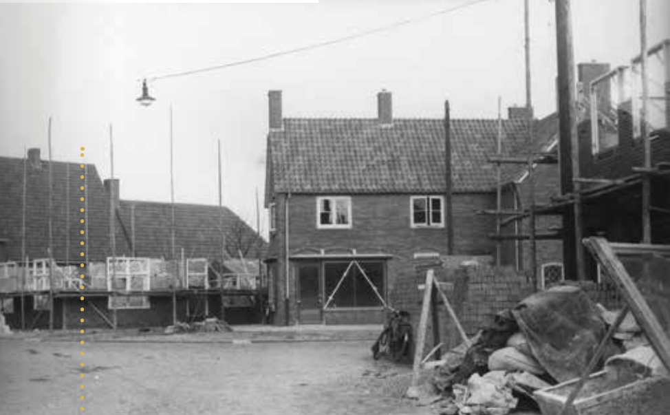
○ Nieuwbouw aan de Hogestraat in Dinxperlo
