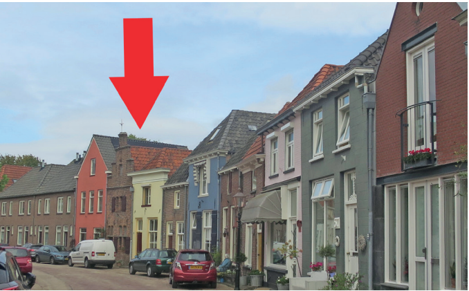
Bergstraat in Doesburg aan voorzijde. De zonnepanelen die de rode pijl aanwijst, vallen nauwelijks op in het straatbeeld. Hier is er een goede balans tussen duurzaamheid en ruimtelijke kwaliteit.
