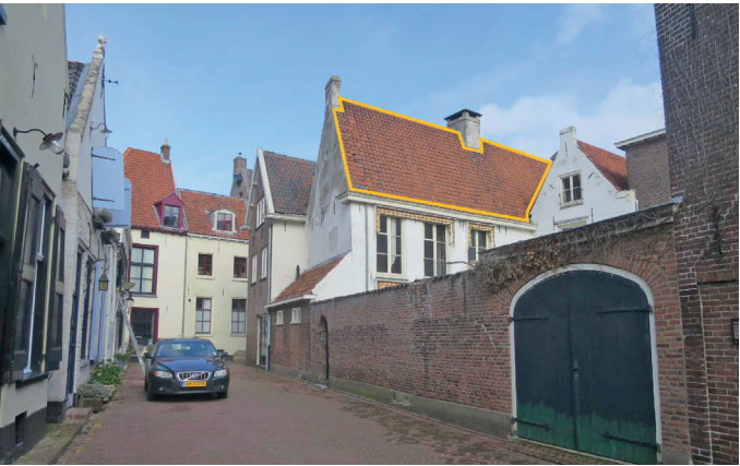
Het geel omrande zijdakvlak ligt volledig in het zicht en is dus niet geschikt voor zonnepanelen.
