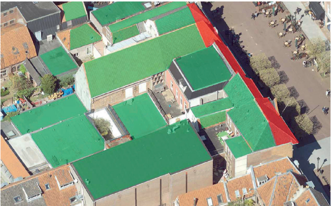
Daken in rood (geen zonnepanelen) en groen (mogelijkheid voor zonnepanelen) langs Markt Culemborg. Dan blijkt ineens hoeveel dakvlak er in een monumentale binnenstad nog geschikt is voor zonnepanelen.
